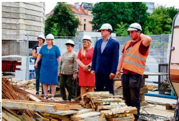
Teren budowy wizytował wicemarszałek Łukasz Porycki – na zdjęciu drugi od prawej.
