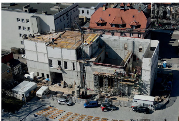
Trzykondygnacyjny budynek Sceny Lalkowej LT, który powstaje na pl. Teatralnym, pomieści m.in. scenę o powierzchni ponad 51 mkw, widownię na 124 miejsca, garderoby, szatnie, magazyny, we foyer będzie przestrzeń wystawowa. Projekt „Modernizacja Lubuskiego Teatru w Zielonej Górze” współfinansowany jest ze środków Europejskiego Funduszu Rozwoju Regionalnego w ramach Regionalnego Programu Operacyjnego – Lubuskie 2020. Wartość projektu 15 295 801, fundusze europejskie 7 970 108, z budżetu państwa 841 123.
