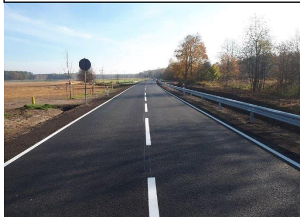
Odnowa dywanikowa drogi woj. nr 283 (Lasocin)
