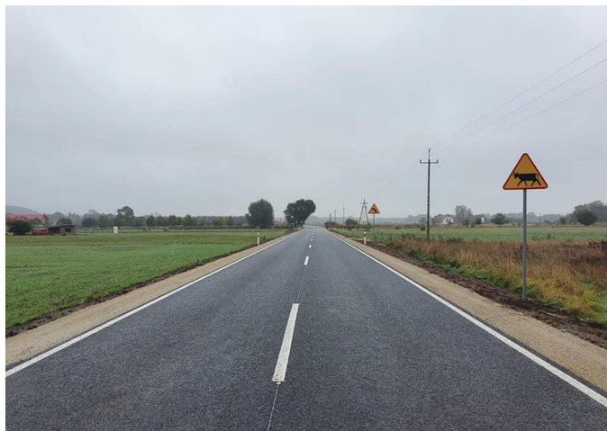
Odnowa dywanikowa drogi woj. nr 174 Drezdenko – Stare Bielice
