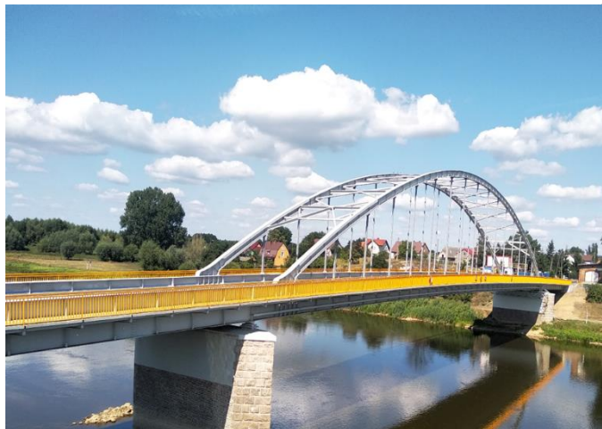
Przebudowa mostu przez rzekę Wartę w miejscowości Świerkocin w ciągu drogi woj. nr 131
