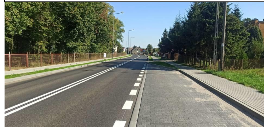
Przebudowa i rozbudowa drogi woj. nr 158 na odc. Drezdenko – Gorzów Wlkp.
