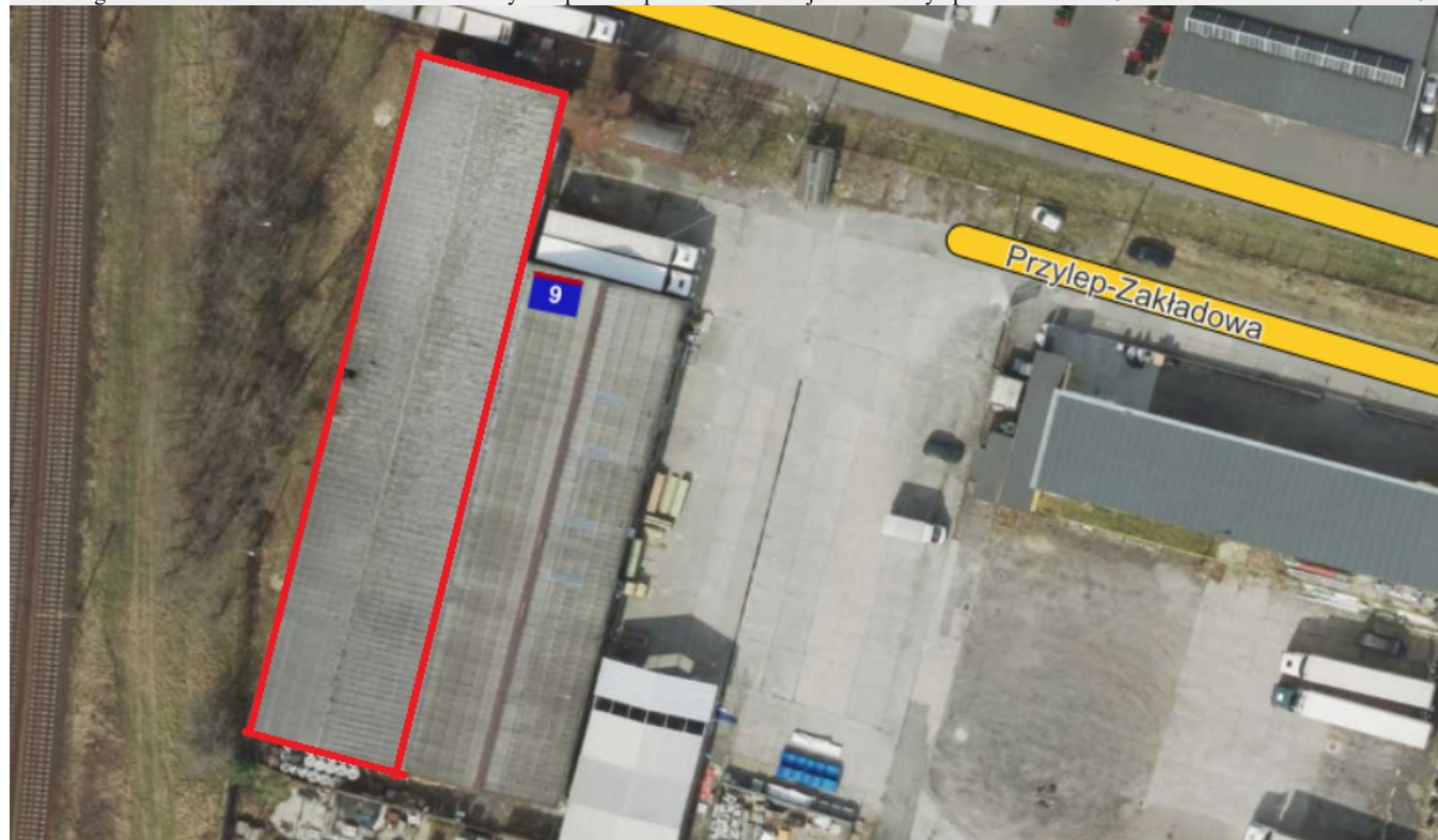
Rys.3 Hala magazynowa odpadów Zielona Góra – Przylep, ul Zakładowa 3
