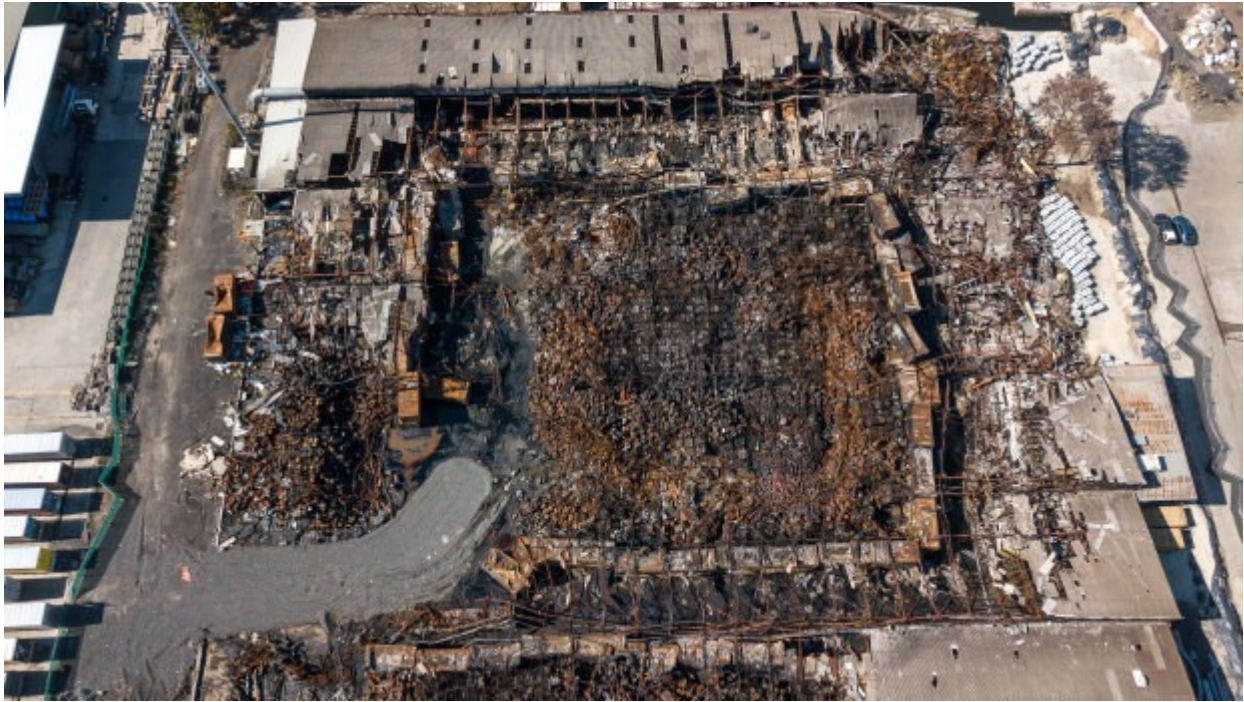
Fot.8 Pogorzelnisko. The site of the chemical fire in West Footscray / Tottenham. JUSTIN MCMANUS . Pogorzelniska odpadów niebezpiecznych, chemicznych są podobne. Zgliszcza spalonych pojemników. W tym przypadku również zniszczony dach z płyt azbestowo -cementowych
