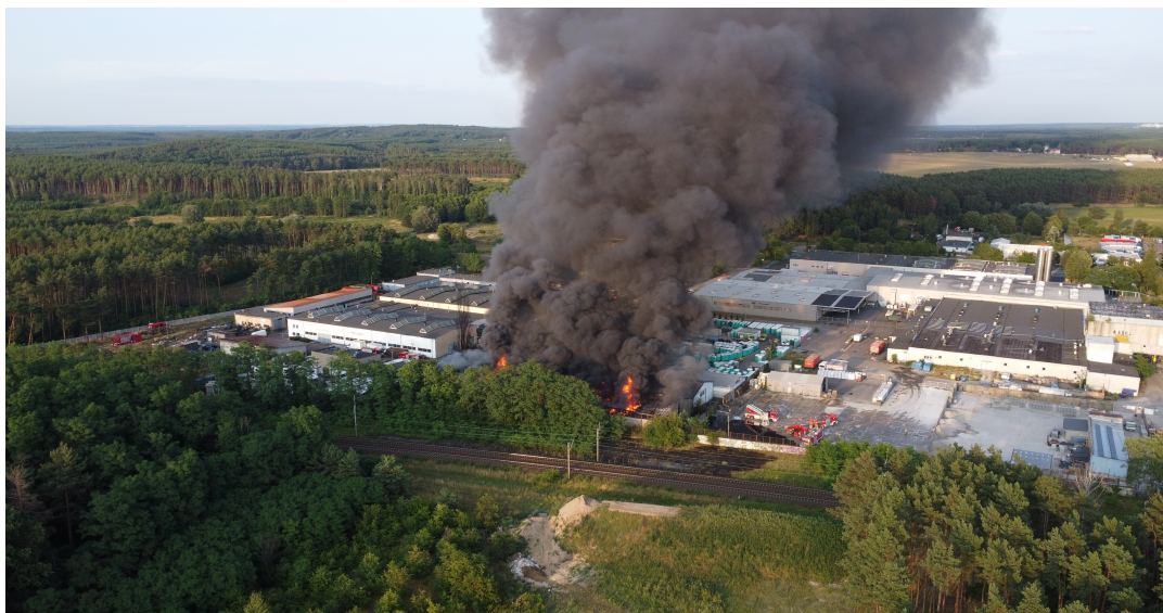
Fot.2 Pożar hali magazynowej z odpadami niebezpiecznymi 8
