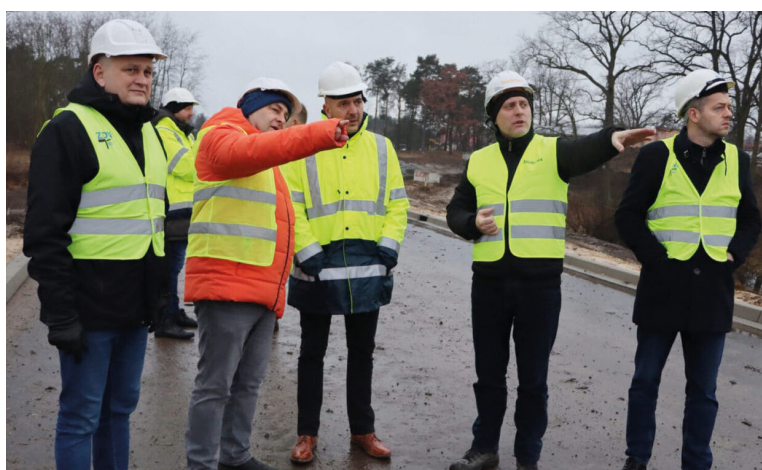
Powstaje droga klasy G, czyli jednojezdniowa, dwupasowa. Każdy pas ruchu będzie miał 3,5 m
