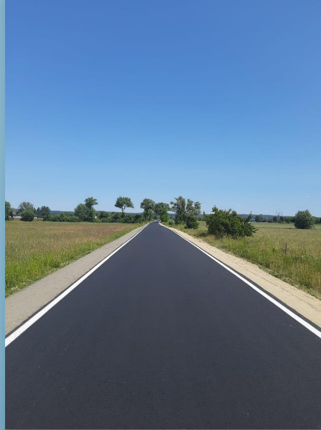
DW 155 na odc. dł. 3,523 km
