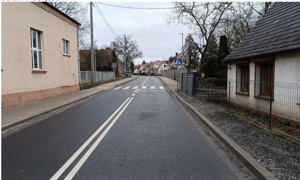
Rys.3. Rozbudowa drogi wojewódzkiej nr 294 w m. Trzebiel na odcinku od km 0+815 do km 1+064,583
