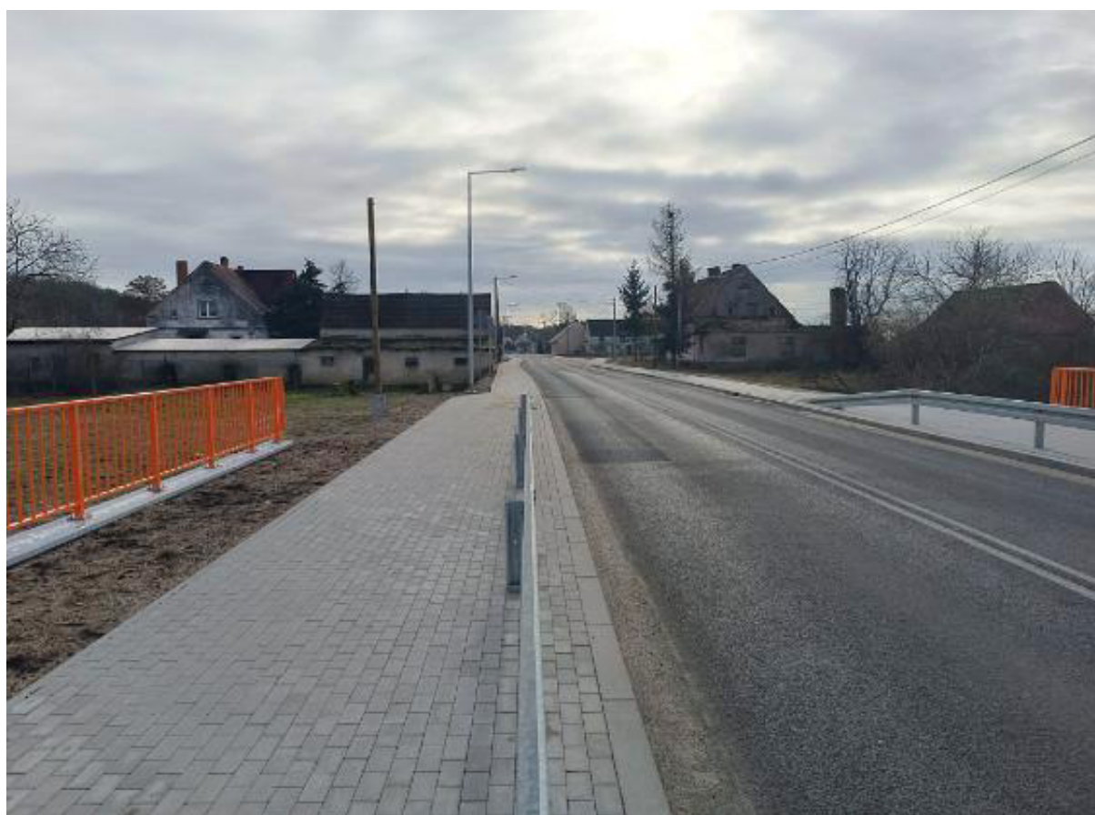
Rys.11. Rozbudowa drogi wojewódzkiej nr 295 w m. Miodnica
