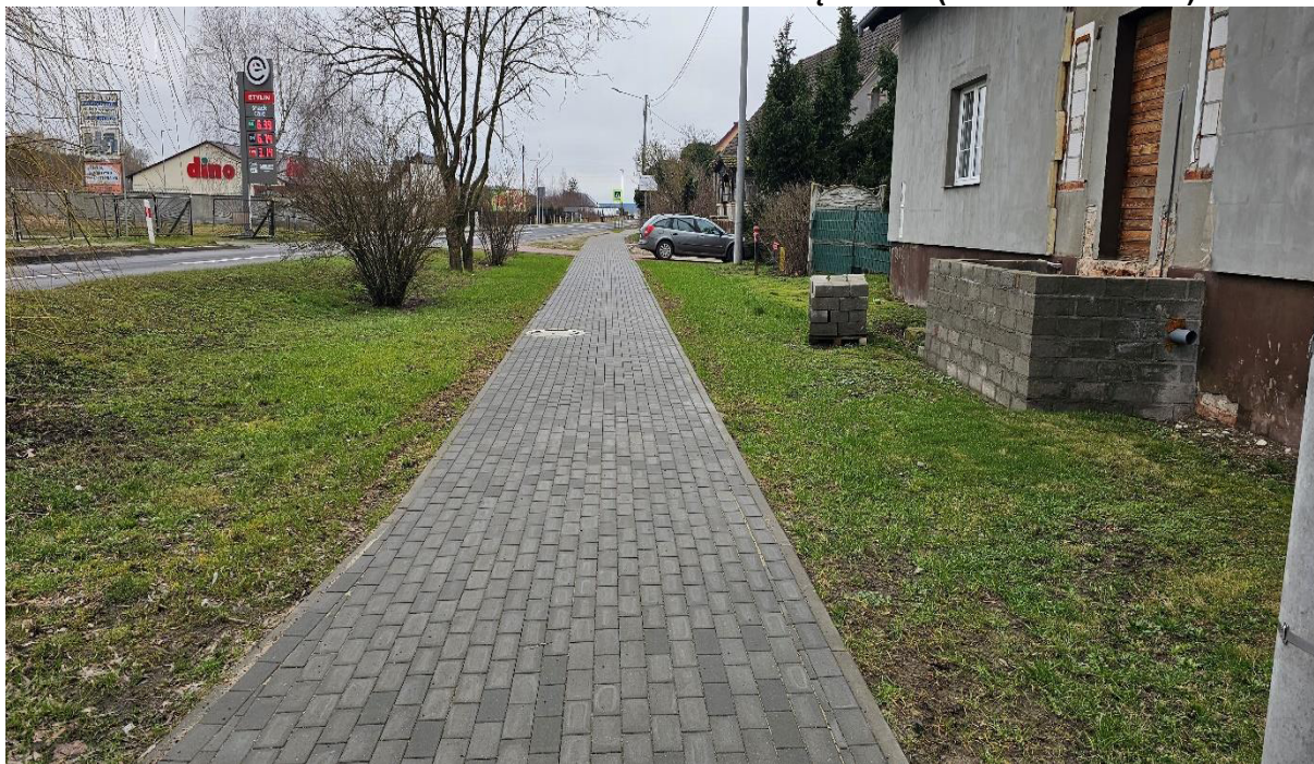
Rys.5. Przebudowa drogi polegająca na budowie chodnika na drodze wojewódzkiej nr 278 od km 38+637 do km 38+723 na dz. nr 95/3 obręb 0009 (m. Trzebiechów)
