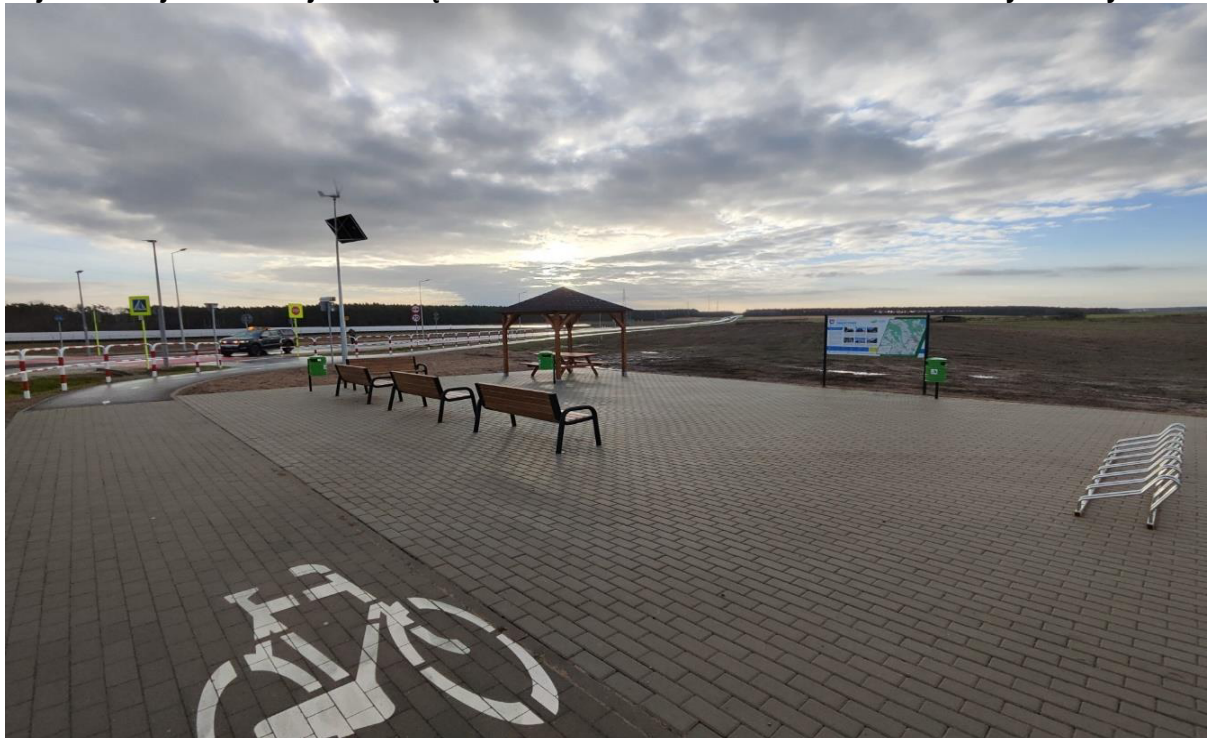
Rys.10. Budowa obwodnicy m. Podmokle Wielkie, Kosieczyn i Chlastawa w ciągu drogi wojewódzkiej nr 302 - dojazd do węzłów na autostradzie A-2 w Trzcielu oraz Nowym Tomysłu
