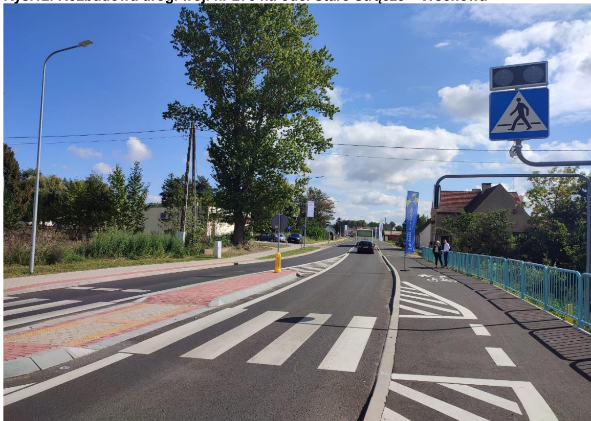
Rys.12. Rozbudowa drogi woj. nr 278 na odc. Stare Strącze – Wschowa
