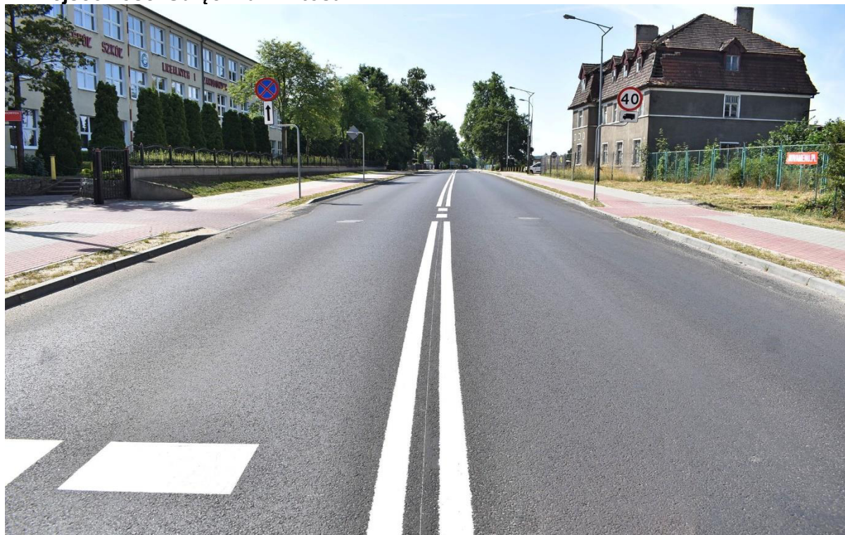
Rys.1. Przebudowa polegająca na odnowie dywanikowej drogi wojewódzkiej nr 138 w miejscowości Sulęcín ul. Witosa
