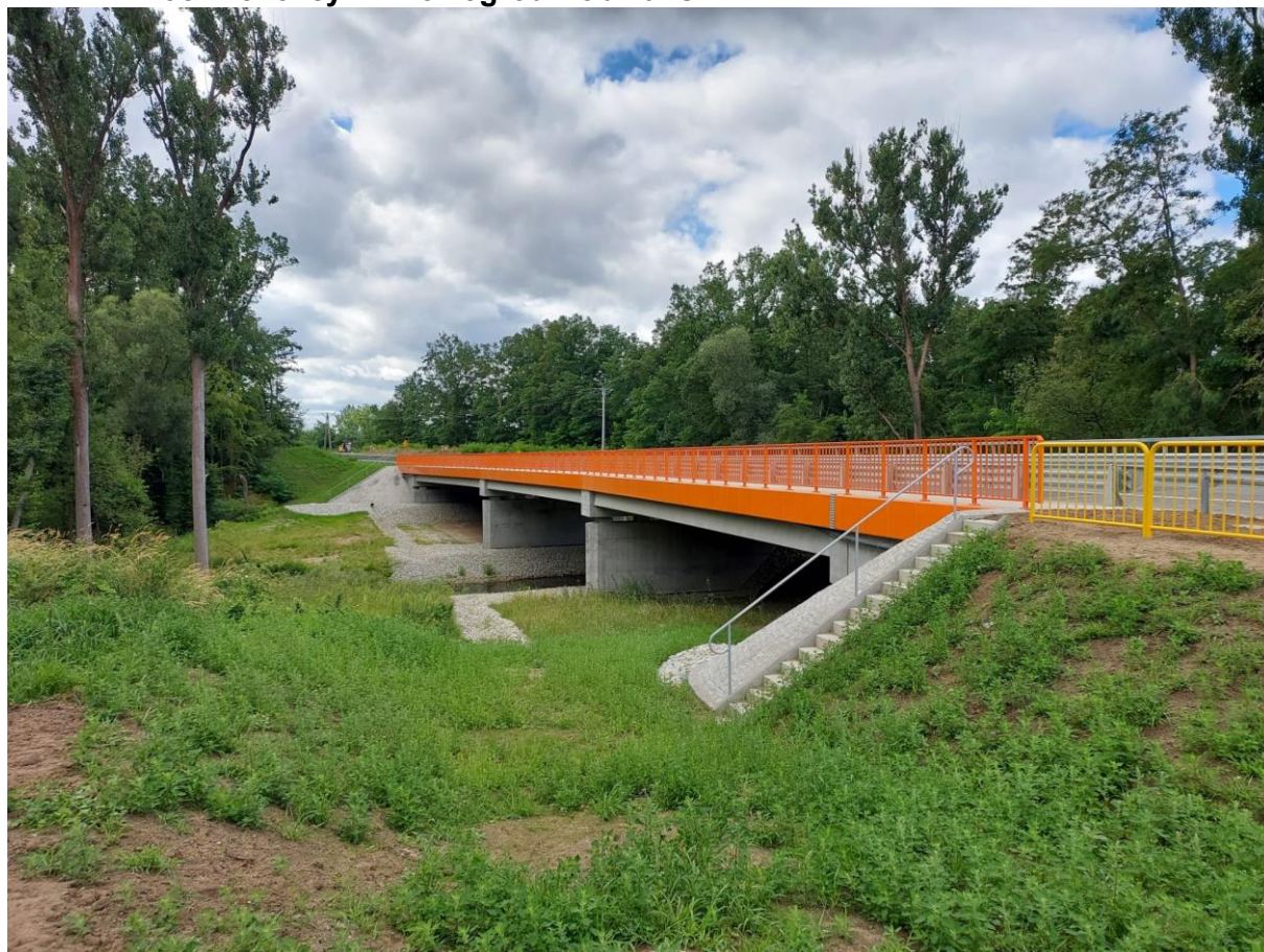
Rys.17. Budowa mostu na rz. Brzeźnica z dojazdami w ciągu drogi wojewódzkiej nr 295 w okolicy m. Nowogród Bobrzański
