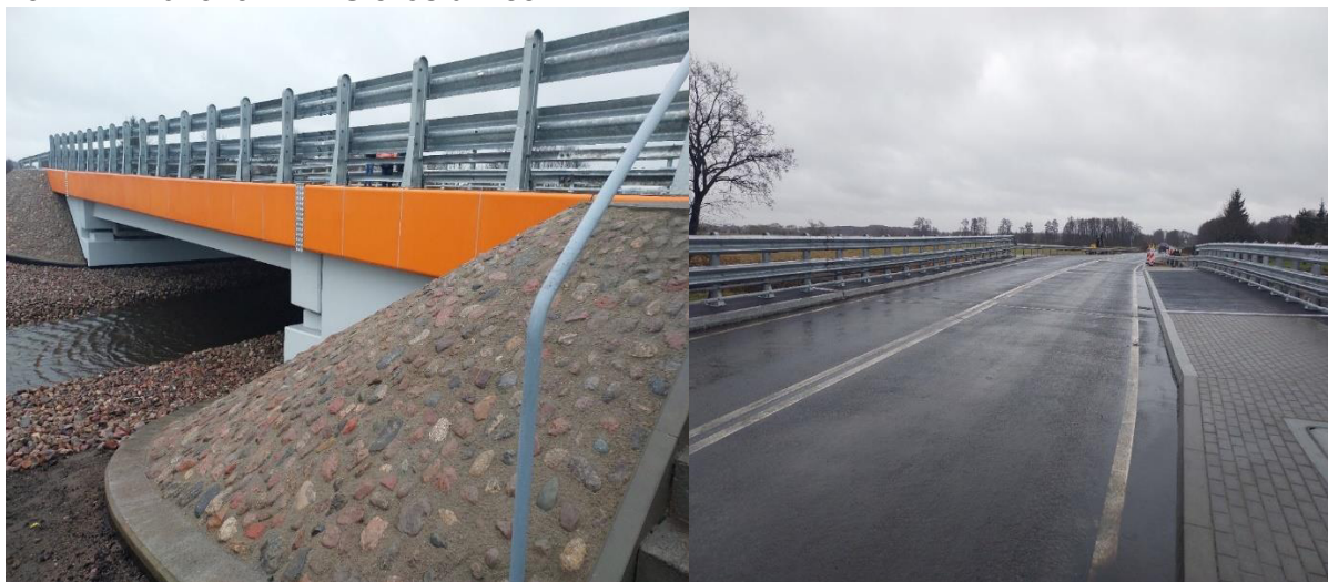
Rys.13. Rozbiórka istniejącego i budowa nowego mostu w ciągu drogi wojewódzkiej 157 w km 0+545 w m. Sierosławice
