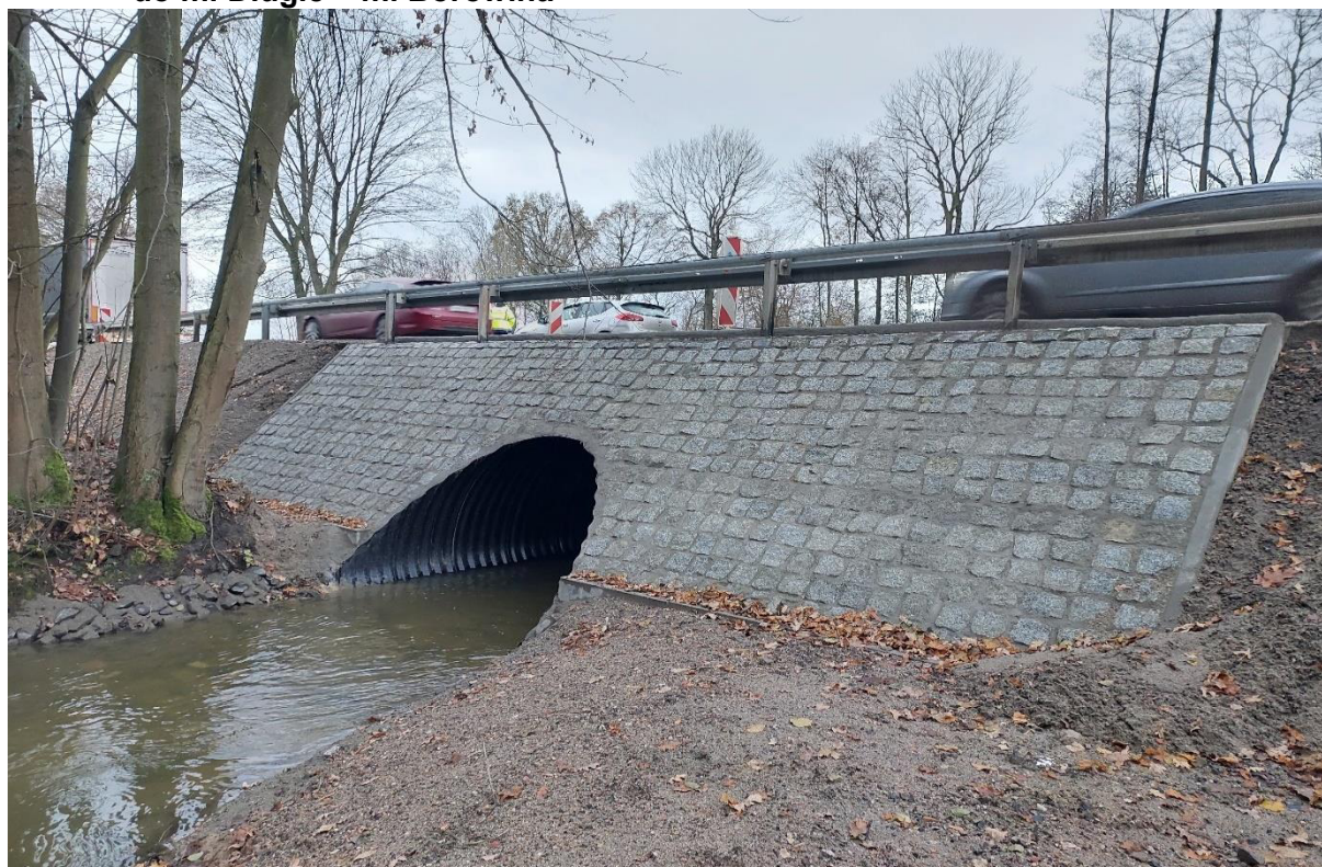
Rys.14. Rozbiórka istniejącego i budowa nowego przepustu zlokalizowanego w km 20+000 w ciągu drogi wojewódzkiej nr 297 na odcinku skrzyżowanie do m. Długie – m. Borowina
