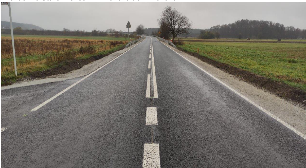
Rys.7. Przebudowa polegająca na odnowie dywanikowej- drogi woj. nr 174 relacji Drezdenko Stare Bielice w km 5+340 do km 6+310
