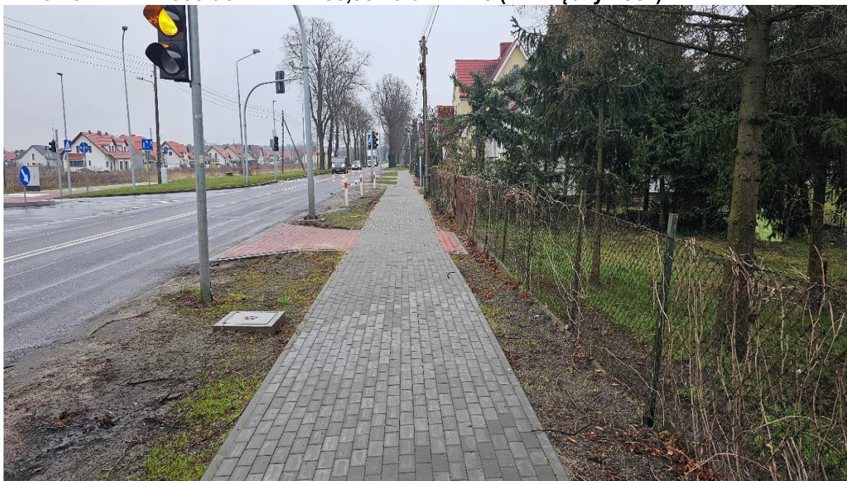
Rys.4. Przebudowa drogi polegająca na budowie chodnika na drodze wojewódzkiej nr 137 ok km 77+035 do km 77+186,95 na dz. nr 78 (m. Międzyrzecz)
