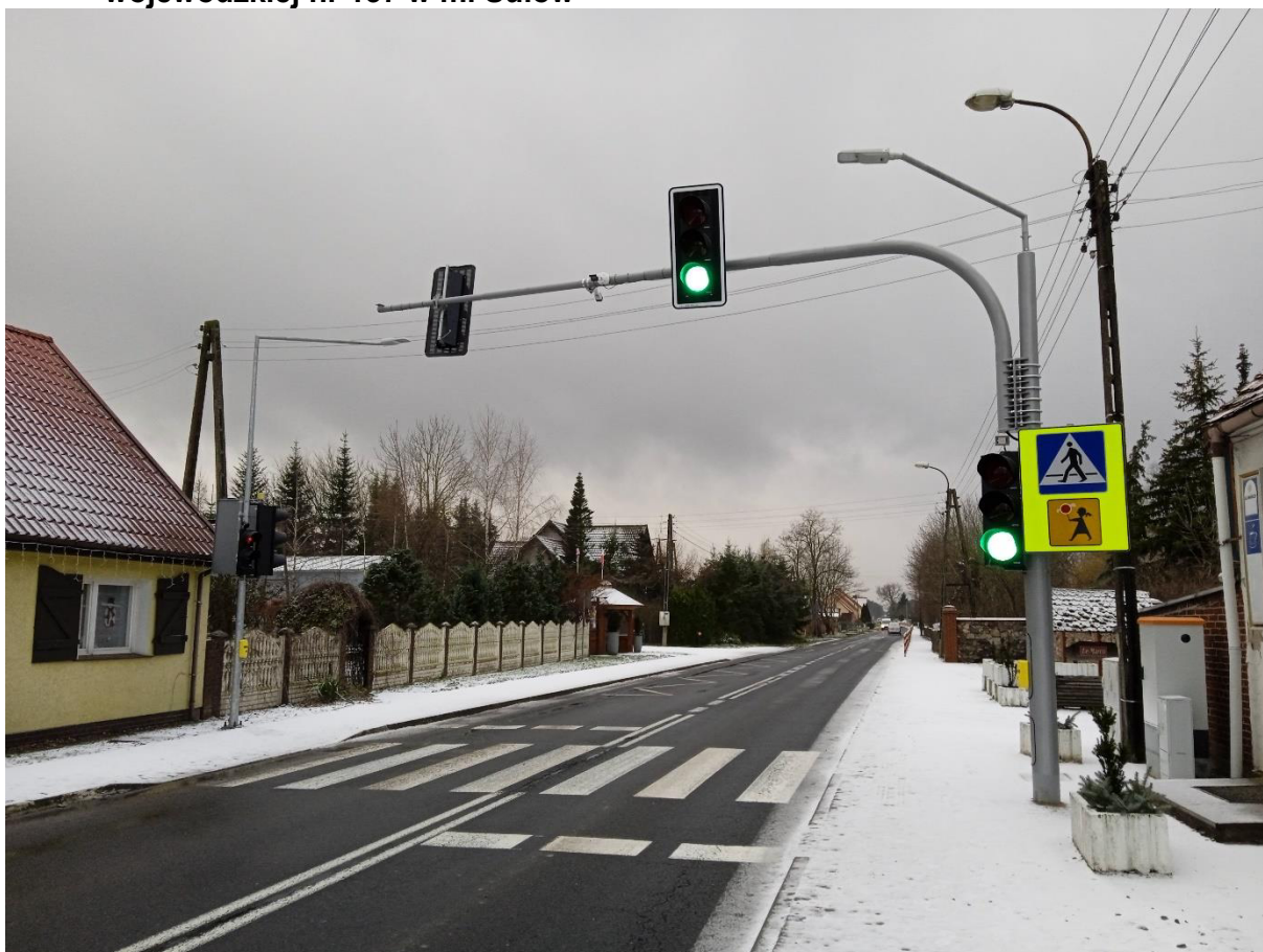
Rys.16. Poprawa bezpieczeństwa w ruchu drogowym poprzez budowę sygnalizacji świetlnej wraz z dedykowanym oświetleniem przejścia dla pieszych na drodze wojewódzkiej nr 137 w m. Sułów
