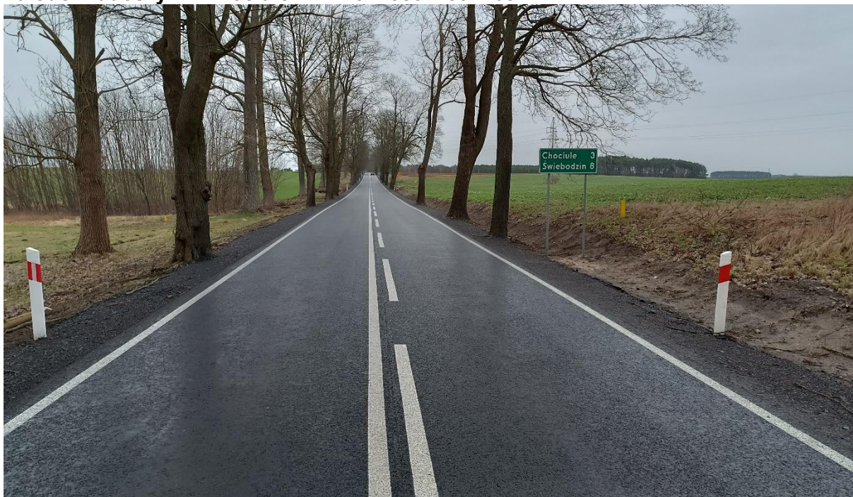
Rys.8. Przebudowa drogi woj. nr 276 relacji Krosno Odrzańskie – Świebodzin na odc. Radoszyn – Chociule w km 32+388 – 33+163
