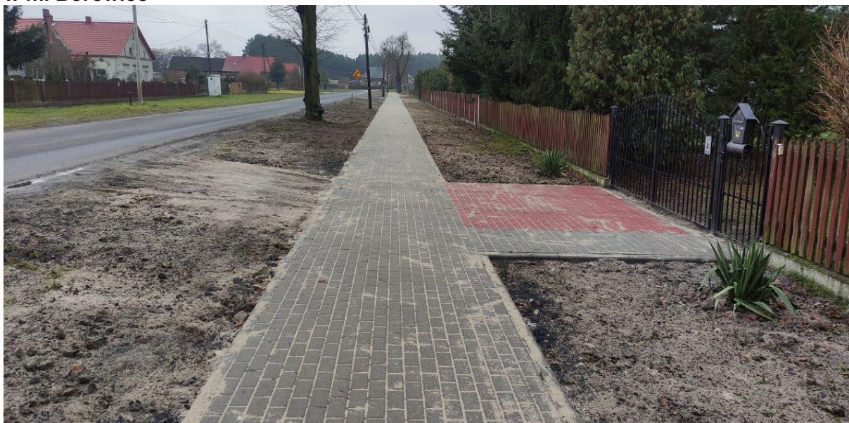
Rys.6. Przebudowa drogi wojewódzkiej nr 325 w zakresie budowy chodnika w m. Borowiec
