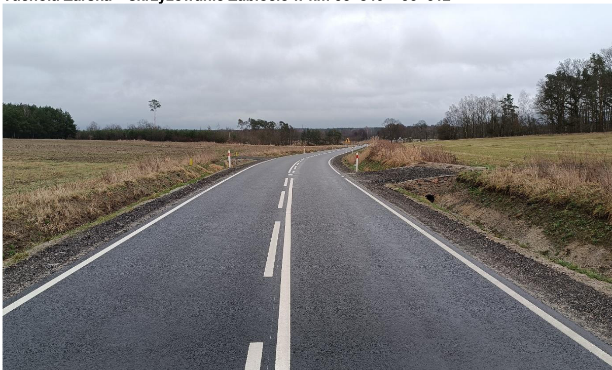
Rys.9. Przebudowa polegająca na odnowie dywanikowej drogi woj. nr 289 odcinek Tuchola Żarska – skrzyżowanie Zabłocie w km 35+840 – 36+612
