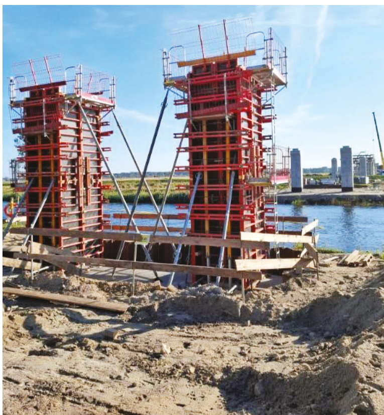
W Drezdenku także chodzi o wyprowadzenie ze ścisłego centrum znacznej części ruchu samochodów. Prace trwają.
