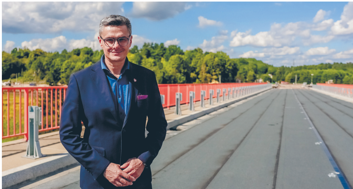
Sebastian Ciemnoczołowski na placu budowy obwodnicy Drezdenka
